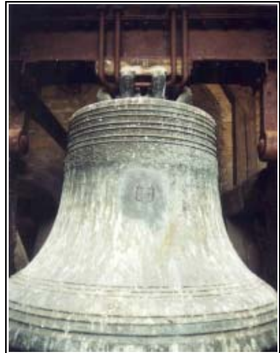
Abb.12: Kirche Neumark (Landkreis Weimarer Land) historische Bronzeglocke von 1601 am gestelzten Stahljoch Gießer: Hermann König, Erfurt Durchm.: 1.380 mm Gewicht: 1.700 kg Nominal: es'-1 Foto: Verfasser
